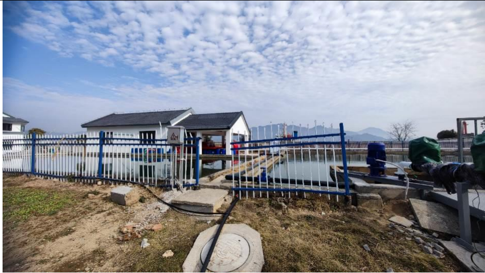
消防水池、消防泡沫储罐
