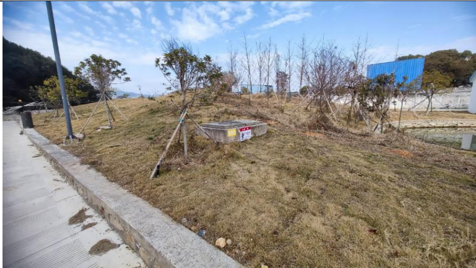
事故应急池（地下）
