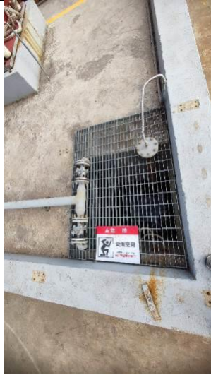
初期雨水收集池
