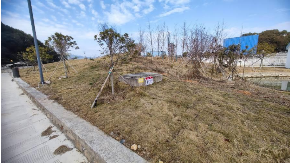
事故应急池（地下）
