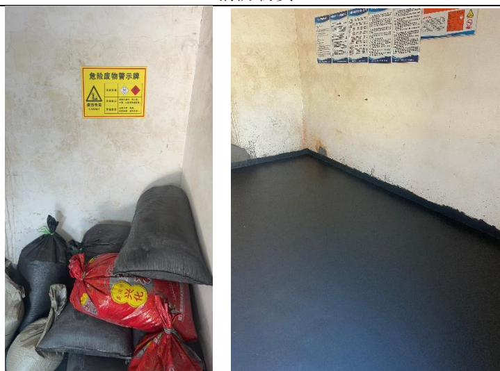
危险废物仓库
