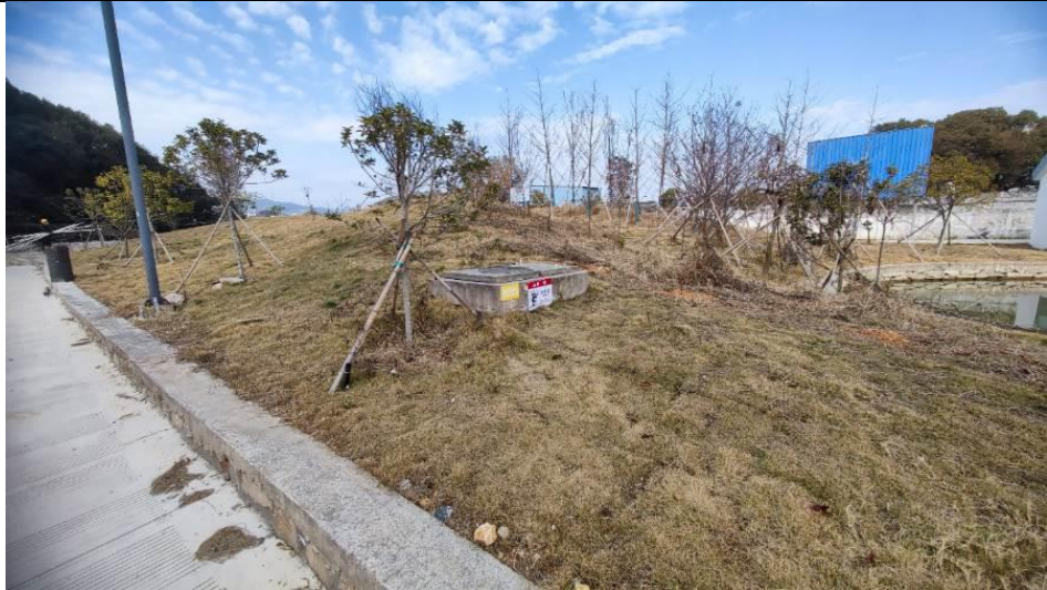
事故应急池（地下）
