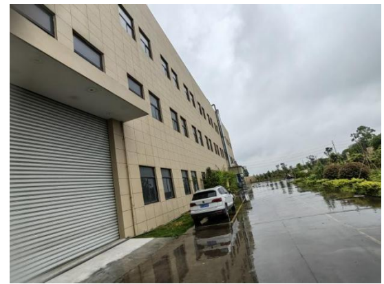
厂区道路（简单防渗区）
