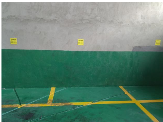
危废暂存间（重点防渗区）
