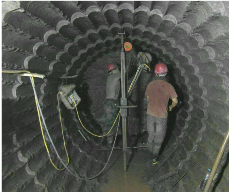
图 3-7 水磨钻取芯+液压镐头机劈岩法施工现场图
