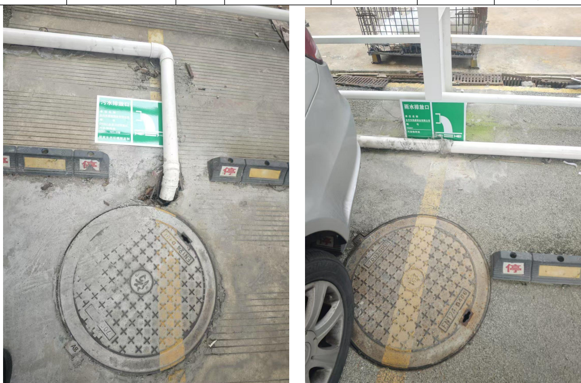
DW001 生活污水排放口
