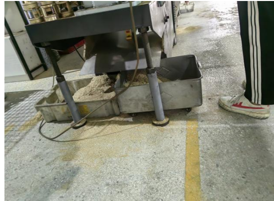
生产车间（一般防渗区）
