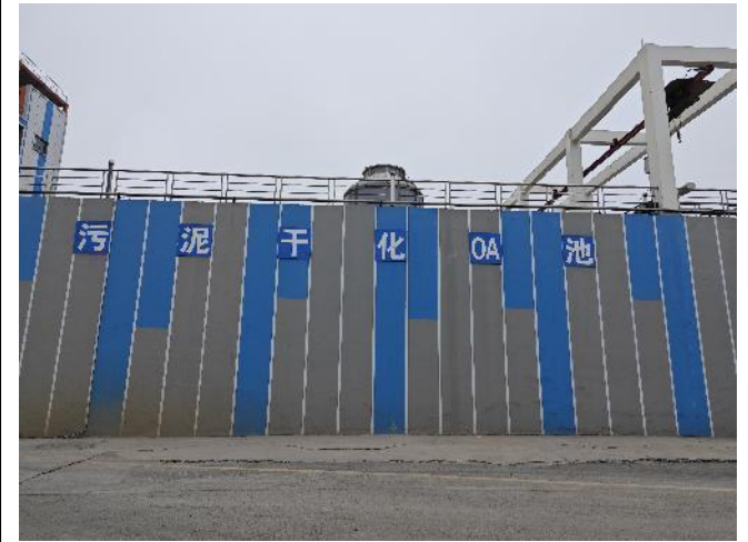
污泥干化废水处理站
