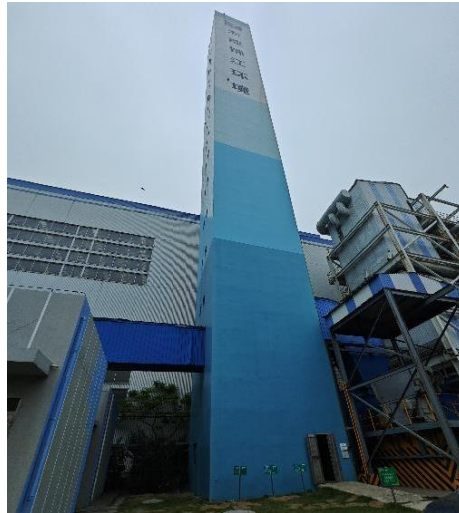
焚烧废气排气筒
