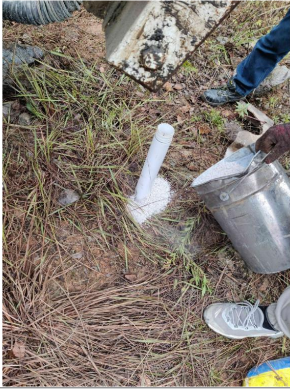
建井加膨润土封口
