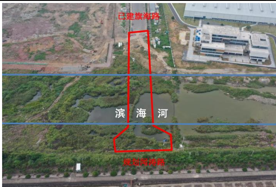
图 3-1 工程沿线现状
