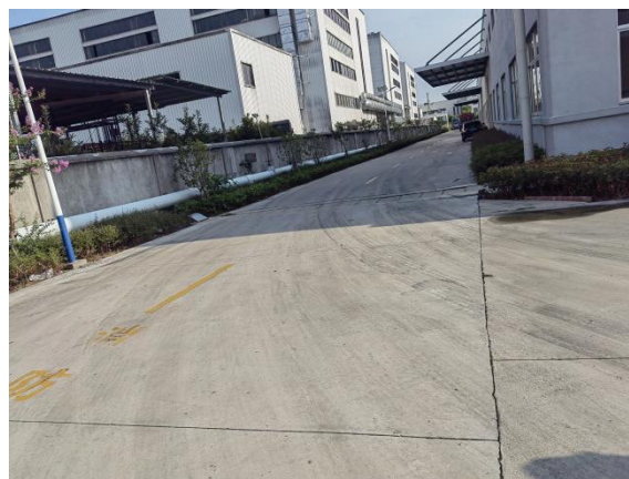
厂区道路（简单防渗区）
