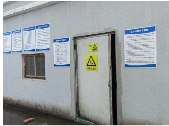
危废仓库（外部）
