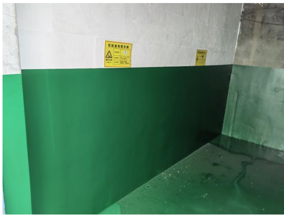
危废仓库（内部）
