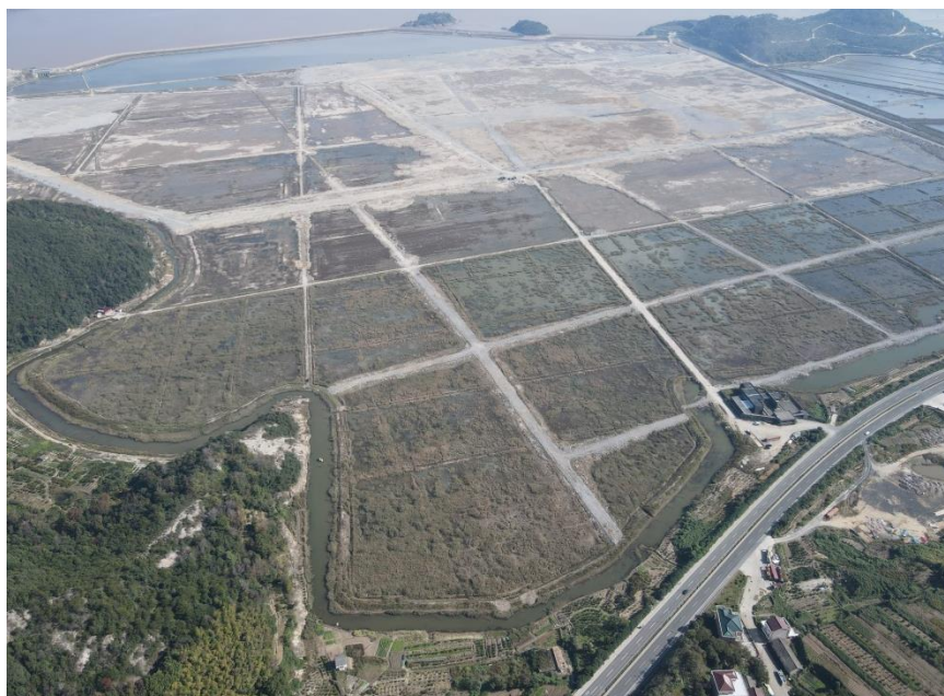
图2-11 三门县洋市涂低洼区改造项目渣土消纳料堆填区域
