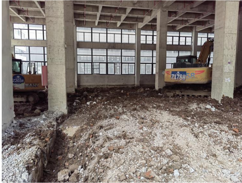
图 2-6 本项目新建厂房照片
