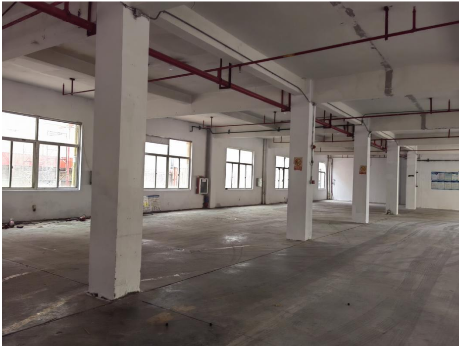
图 2-3 本项目拟使用厂房现状照
