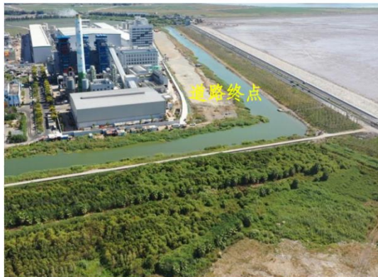
图3-8 道路终点现状
