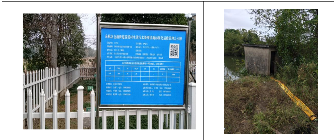
图 3.3-1 污水站和水渠泵房照片
