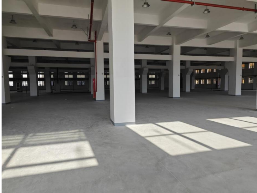
图 2-5 本项目新建厂房照片
