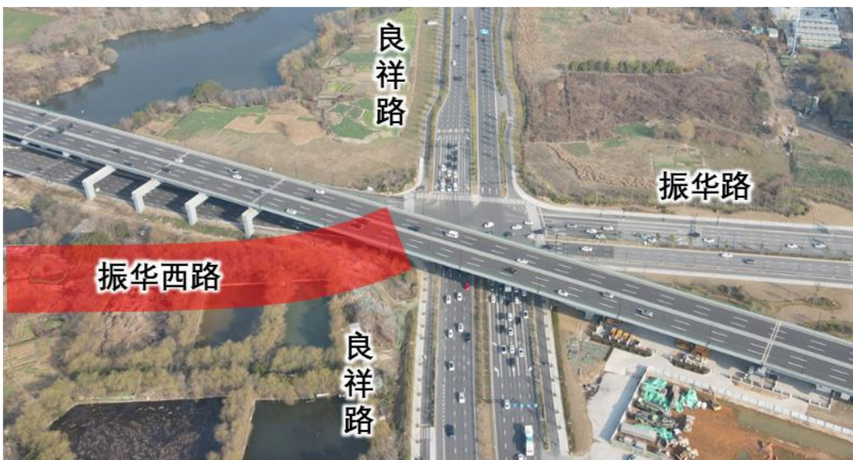
图 2-4 路口现状航拍图
