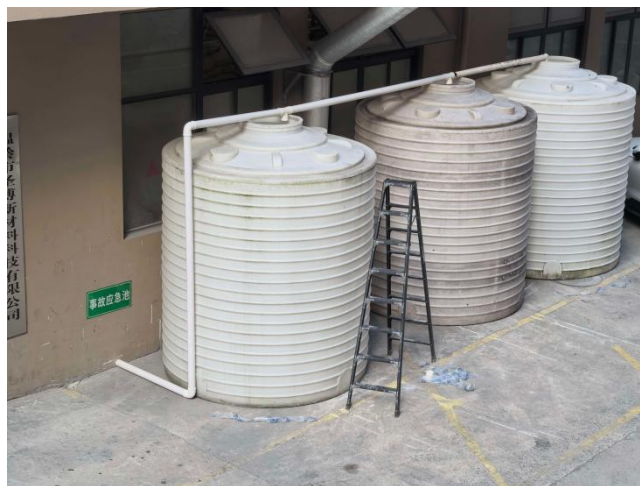
图 3-7 事故应急池照片
